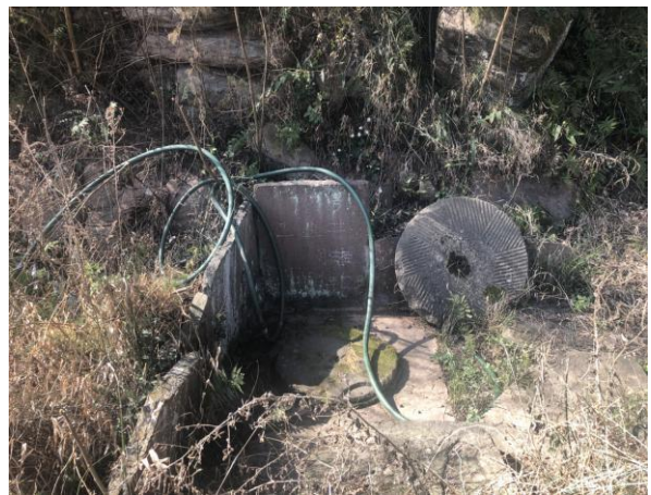
图 3.2-6 南侧农户家水井现场实景图
