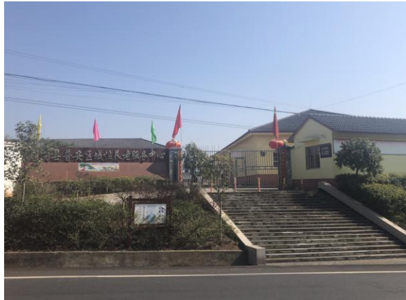
图 3.2-10 普安镇养老院现场实景图
