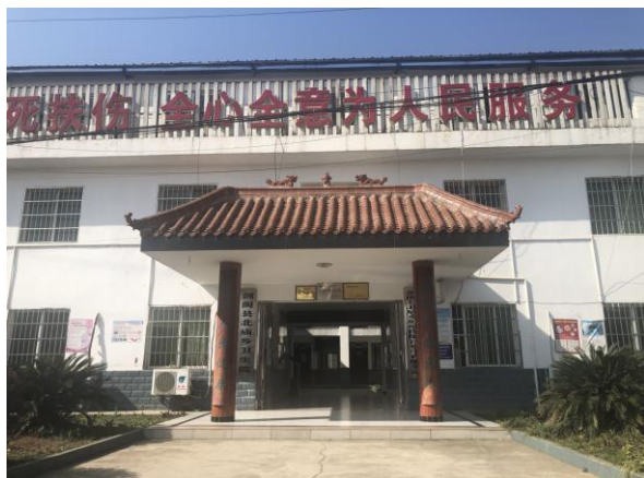
图 3.2-9 石元乡卫生院现场实景图
