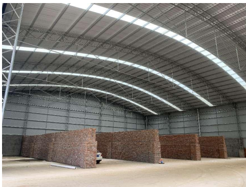
在建原料堆场
