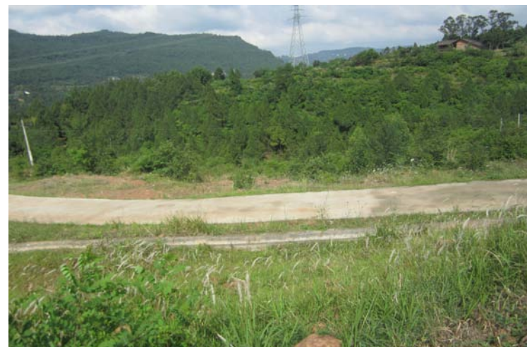
沿线植被恢复情况
