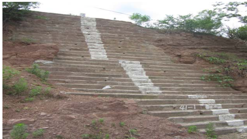
线路护坡情况
