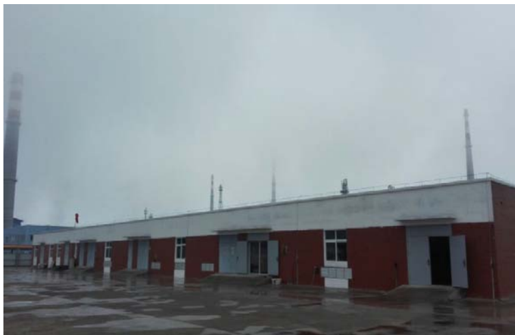
元坝首站值班房
