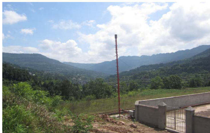
元陆 7 井集气站放空区
