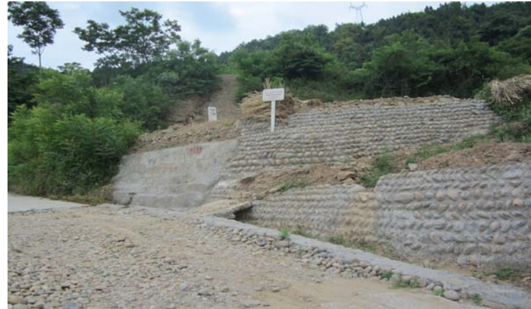
低山区管道作业带
